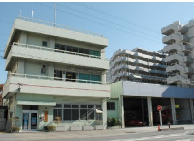
▲庁舎内のレイアウト変更工事が行われる東部分署
