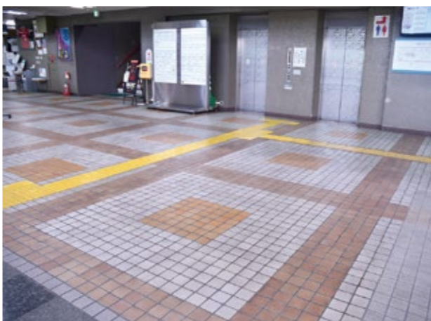
▲改修が予定されている市役所庁舎2階の床面
